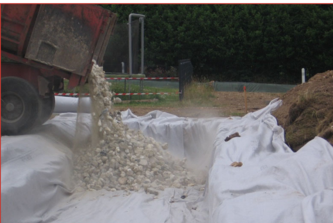
Mise en place de la grave
