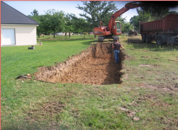
Terrassement du massif drainant
