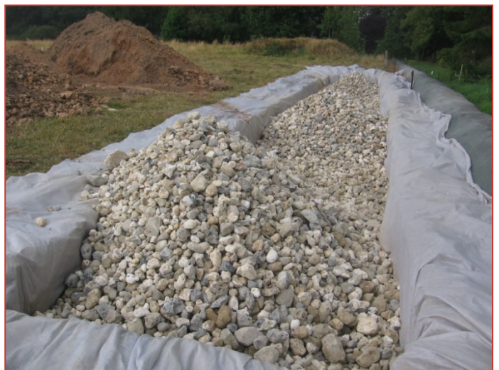
Mise en place du géotextile
