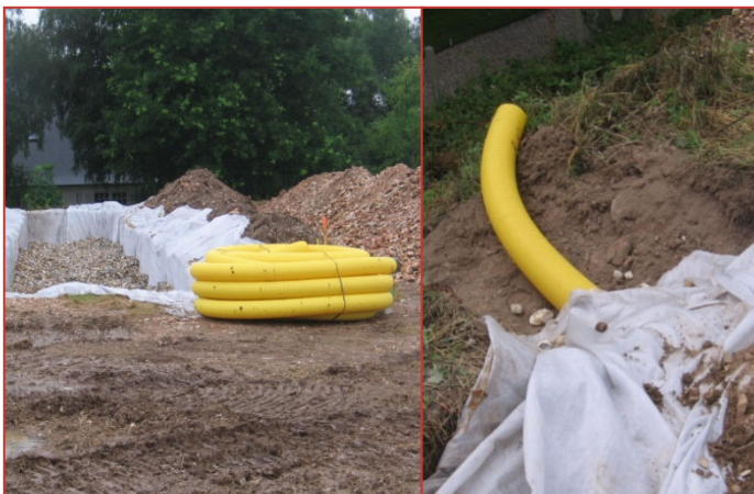
Installation de la canalisation de drainage
