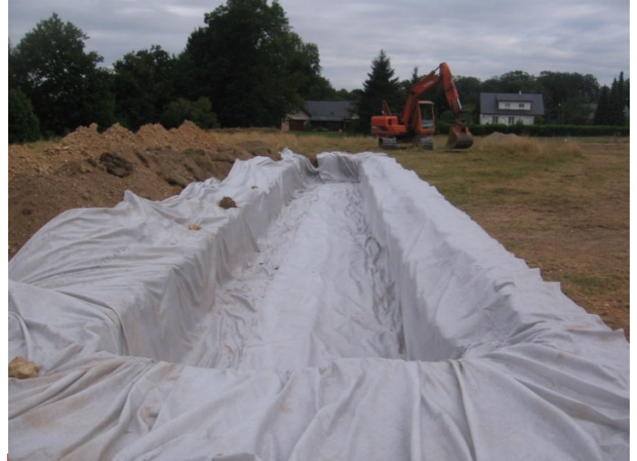
Mise en place du géotextile
