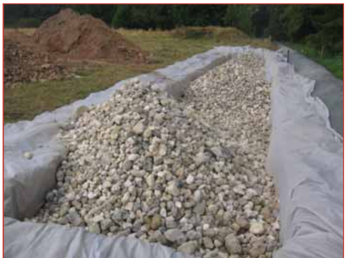
Mise en place du géotextile
