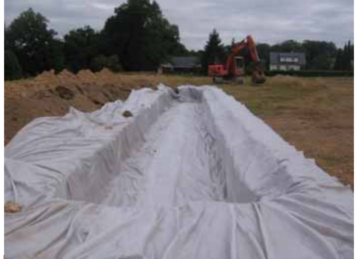
Mise en place du géotextile
