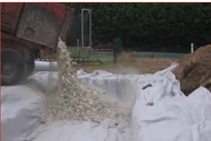
Mise en place de la grave
