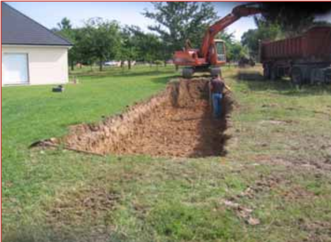
Terrassement du massif drainant
