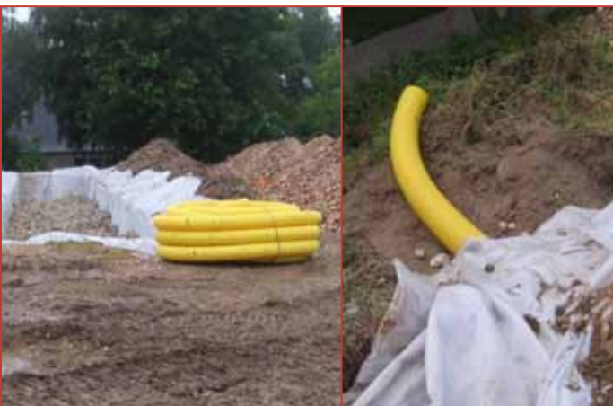
Installation de la canalisation de drainage
