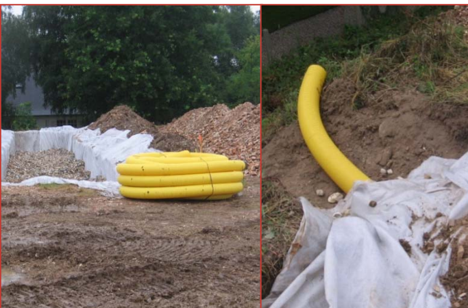
Installation de la canalisation de drainage
