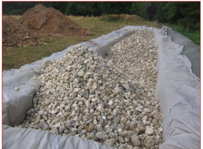
Mise en place du géotextile
