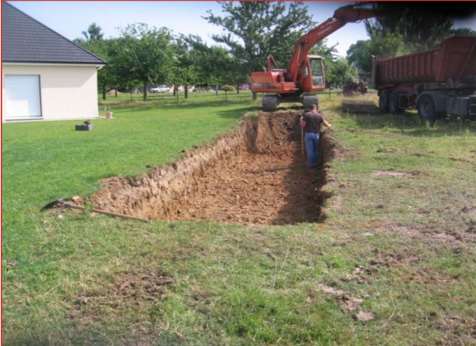
Terrassement du massif drainant
