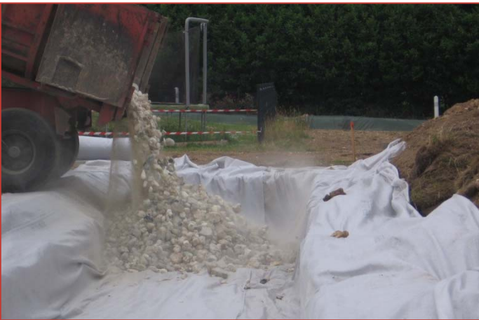
Mise en place de la grave
