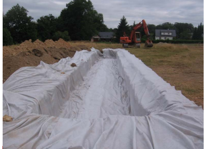
Mise en place du géotextile
