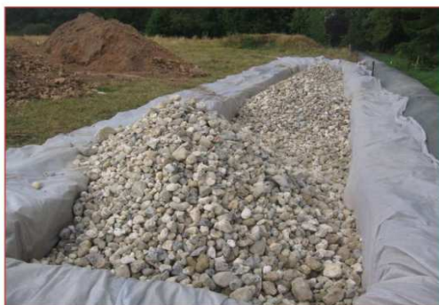
Mise en place du géotextile
