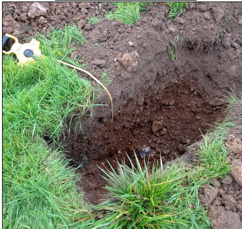
PHOTOGRAPHIE DU SONDAGE
