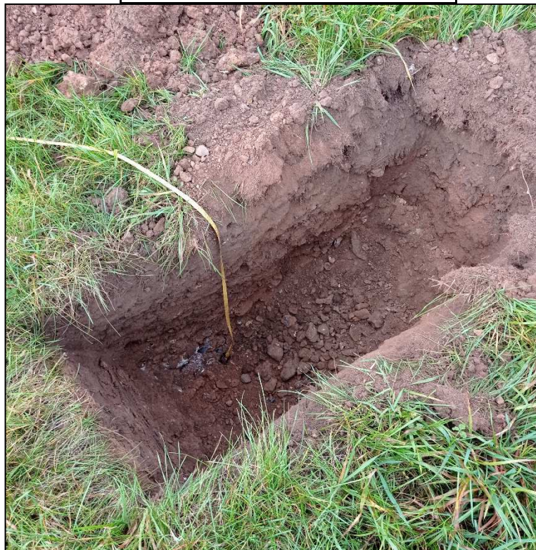
PHOTOGRAPHIE DU SONDAGE
