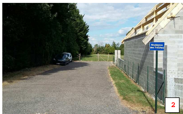
Vue Ouest – Est depuis la voie d'accès au lotissement
