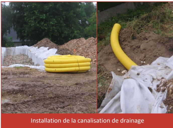
Installation de la canalisation de drainage
