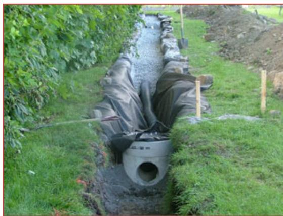
Les massifs drainants sont assimilables à des bassins enterrés, mais remplis de matériaux poreux. Ils se distinguent néanmoins par leurs fonctions hydrauliques et hydrologiques.
